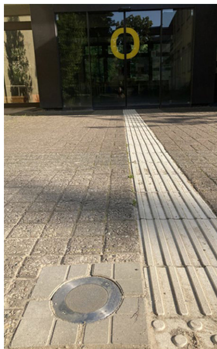
Das Empfangsmodul „LOC.id ROCK“ läuft mit Solarenergie und wird wie ein Pflasterstein ebenerdig verlegt.
